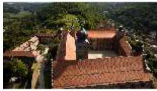
KuPla.I, Luftaufnahme, Blick aus Westen, DI027876, BSV-
