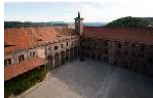
KuPla.I, Luftaufnahme von Westen, Schöner Hof, Uhrturm, DI027881, BSV-
