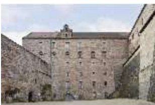
KuPla.I, Fassade vom Arsenalbau, Kasernenhof, DI025706, BSV
