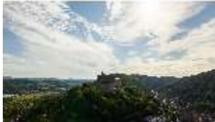
KuPla.I, Luftaufnahme, Blick von Westen, DI027868, BSV-
