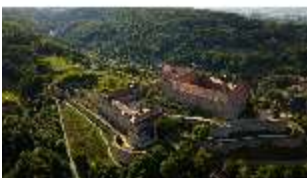
KuPla.I, Luftaufnahme aus Norden, DI027869, BSV-
