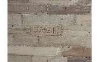
KuPla.I, Gewölbstein mit Initialen FMZBC, Kommandantenbau, DI021611, BSV-
