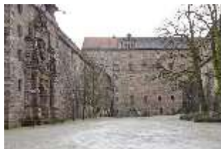
KuPla.I, Fassade vom Arsenalbau, Kasernenhof, DI025707, BSV
