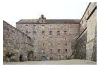
KuPla.I, Fassade vom Arsenalbau, Kasernenhof, DI025705, BSV
