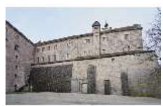
KuPla.I, Kasernenhof (Niederburg), DI025713, BSV
