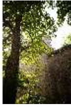
KuPla.I, vom Kasernenhof zur Nordostecke der Hochburg, DI027959, BSV-
