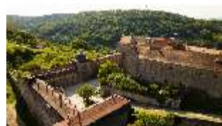
KuPla.I, Luftaufnahme aus Norden, Kasernenhof, DI027873, BSV-
