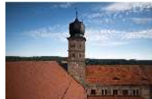
KuPla.I, Luftaufnahme, Blick auf den Wachturm/Wachturm, DI027882, BSV-
