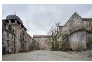
KuPla.I, Kasernenhof (Niederburg), DI025711, BSV
