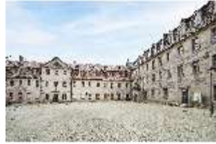
KuPla.I, Ansicht der Großen Kaserne, Kasernenhof, DI021591, BSV-
