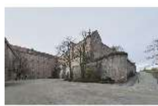
KuPla.I, Kasernenhof (Niederburg), DI025712, BSV
