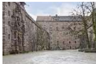
KuPla.I, Fassade vom Arsenalbau, Kasernenhof, DI025708, BSV
