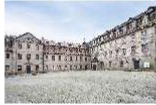
KuPla.I, Ansicht der Großen Kaserne, Kasernenhof, DI021592, BSV-
