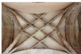
KuPla.I, Südflügel, 2. Joch, 1. OG, Rippengewölbe, DI017510, BSV-
