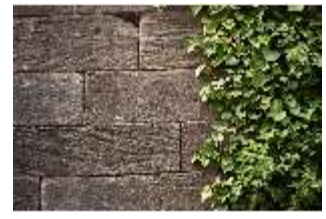
KuPla.I, Kasernenhof, Efeu an der Mauerwand, DI027967, BSV-
